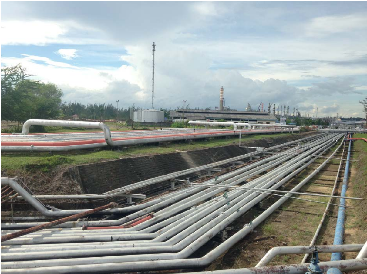
Pipeline-Netz zur Verbindung der Terminals mit einer Raffinerie, Balikpapan, Indonesien (Quelle: Breul 2017)
